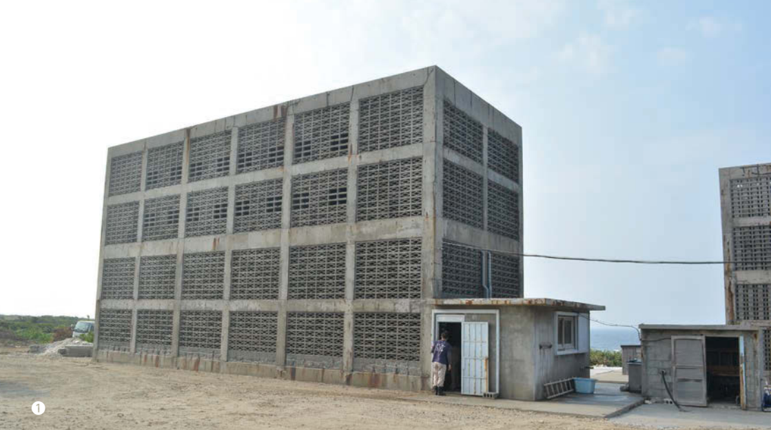
①「かん化式塩田タワー」。穴のあいたブロックできている ②沖縄海塩研究所の奥原リーダー ③栗国島北岸の風 ④15,000本の逆さまに吊るされた竹。シャバシャバシャバ……と海水が落ち続ける
