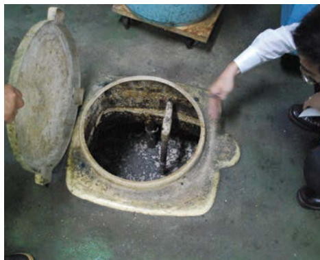
地下のタンクからポンプでバットにくみ出す
