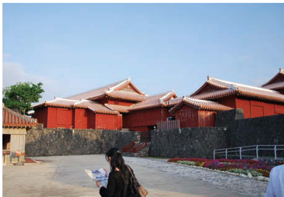
取材日、工事中だった首里城の城郭にて
